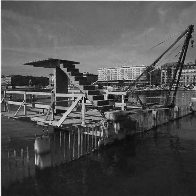
▼ Etat en cour de restauration
