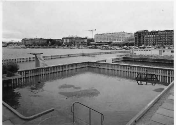
▲ Les bains rénovés en 1995
