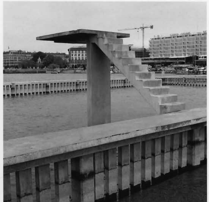
▼ Etat après restauration
