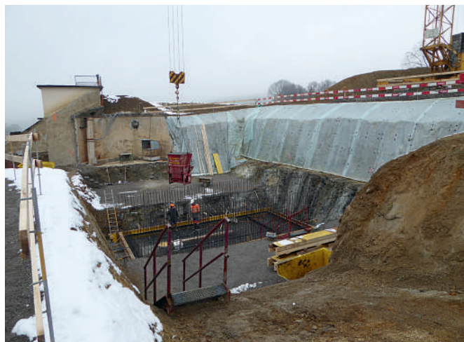
Baugrube für das neue Reservoir Rütli (Ersatzbau) (im Hintergrund altes Reservoir mit einer abgebrochenen Wasserkammer)
