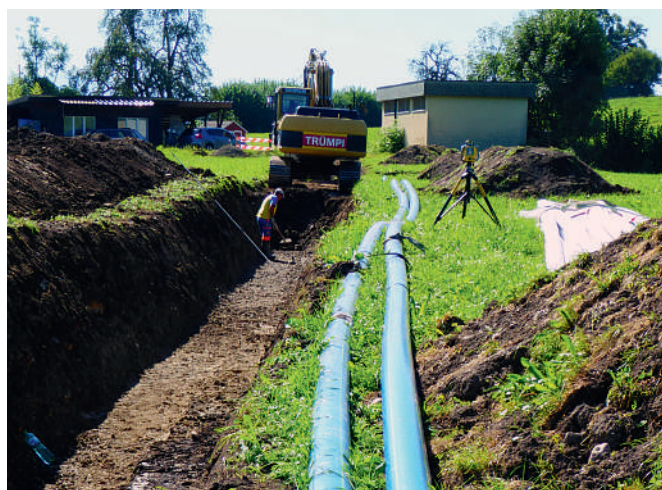
Rohrlegung Gebiet Ächeltswil bis Reservoir Rüti
