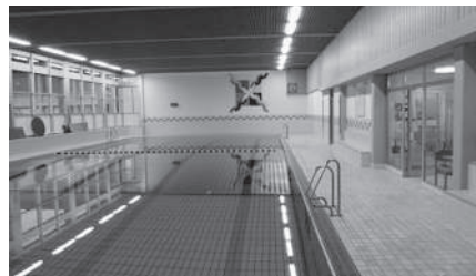
Schwimmbad nach Teilsanierung
