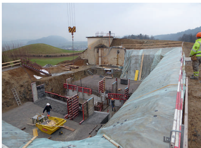
Bauarbeiten am neuen Reservoir Rüti
