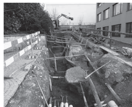
Bauarbeiten Haselgässchen 1. Etappe
