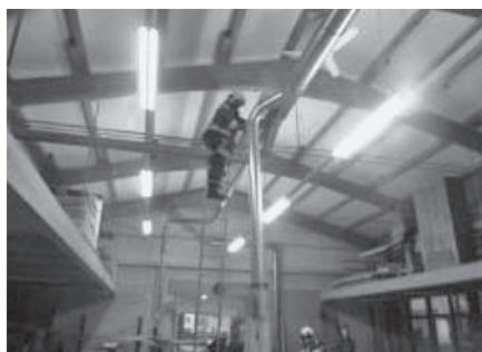
Im Einsatz bei einem Mottbrand in einer Absauganlage.
