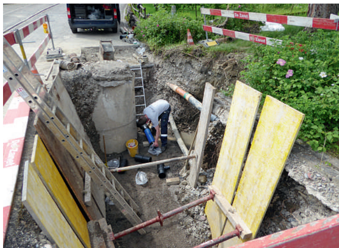
Werkleitungsbau an der Bifangstrasse
