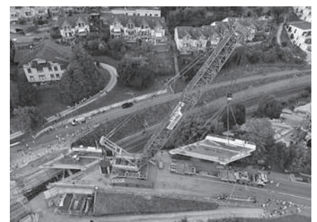
Kran legt 240-Tonnen-Fahrbahnsteil ein
