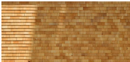
Holzschindelfassade Holzschindeln 3x7mm Breite 85-145mm, Fachweite 80mm Randschindeln, Lärche, gerade, sägeroh
