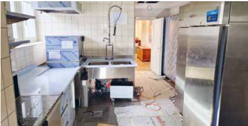
Die mit neuen Installationen erweiterte Küche ist per 1. Oktober betriebsbereit.
