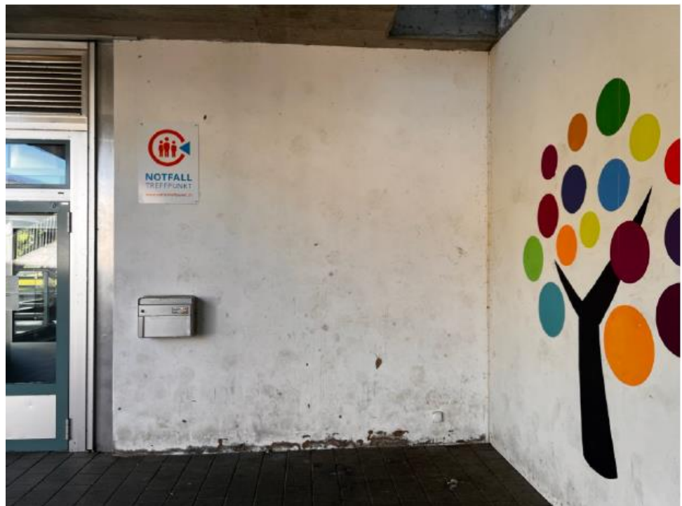
Schulhaus Sockelgeschoss. Eingang Gemeindesaal
