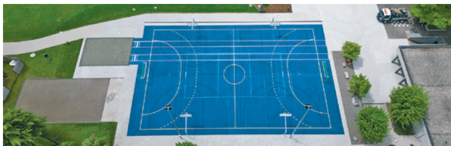
Der sanierte Allwetterplatz der Oberstufe Lerchenfeld
