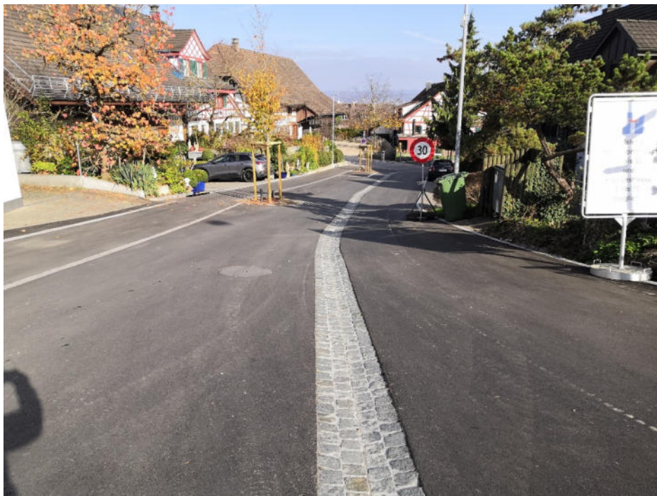
Abbildung 40: Beispielbild einer mittigen Strassenentwässerung
