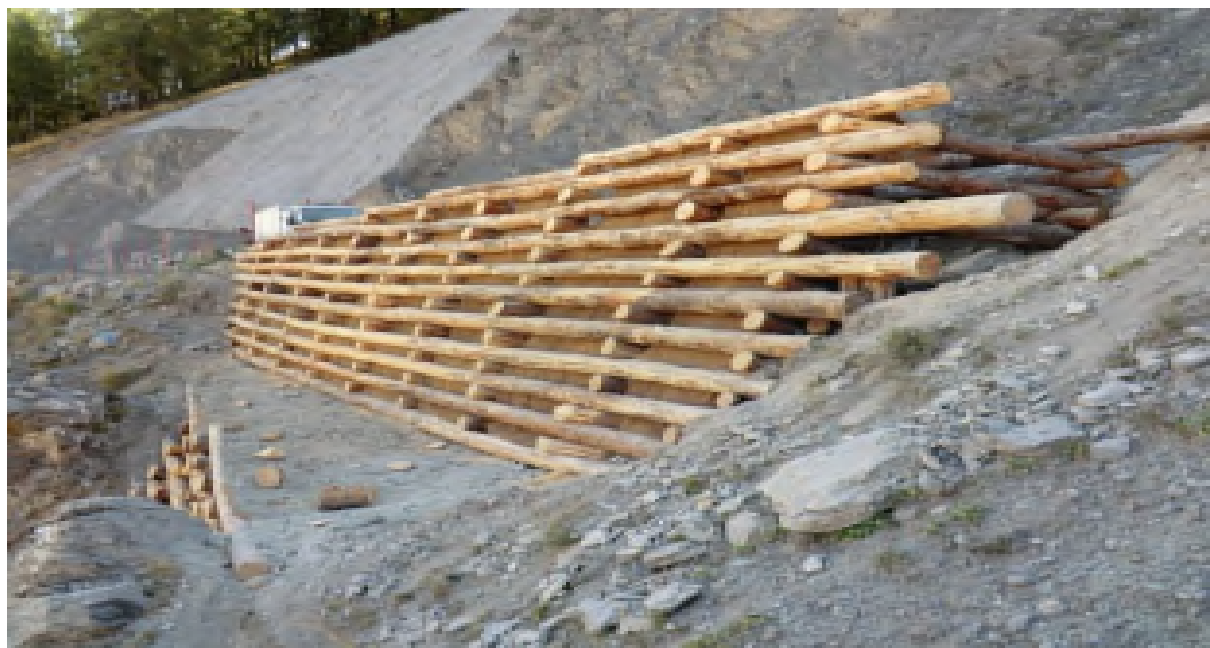
Exemple d'un caisson en rondins de bois tiré du rapport Karakas & Français SA, annexé au présent préavis
