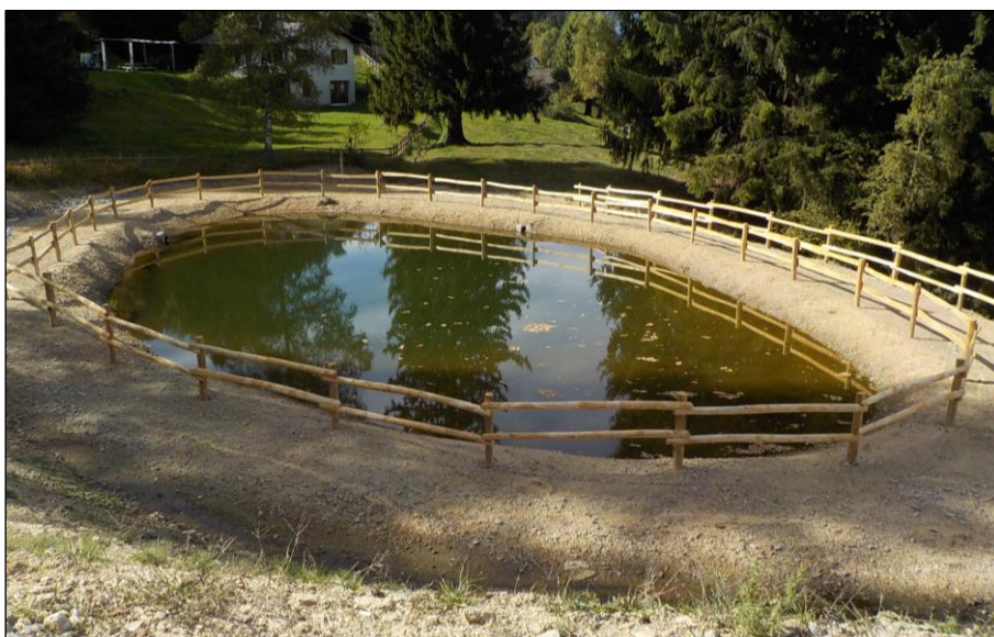
Figura 15: Protezione d'accesso al bacino con recinzione in castagno a doppia stanga (bacino Laura).
