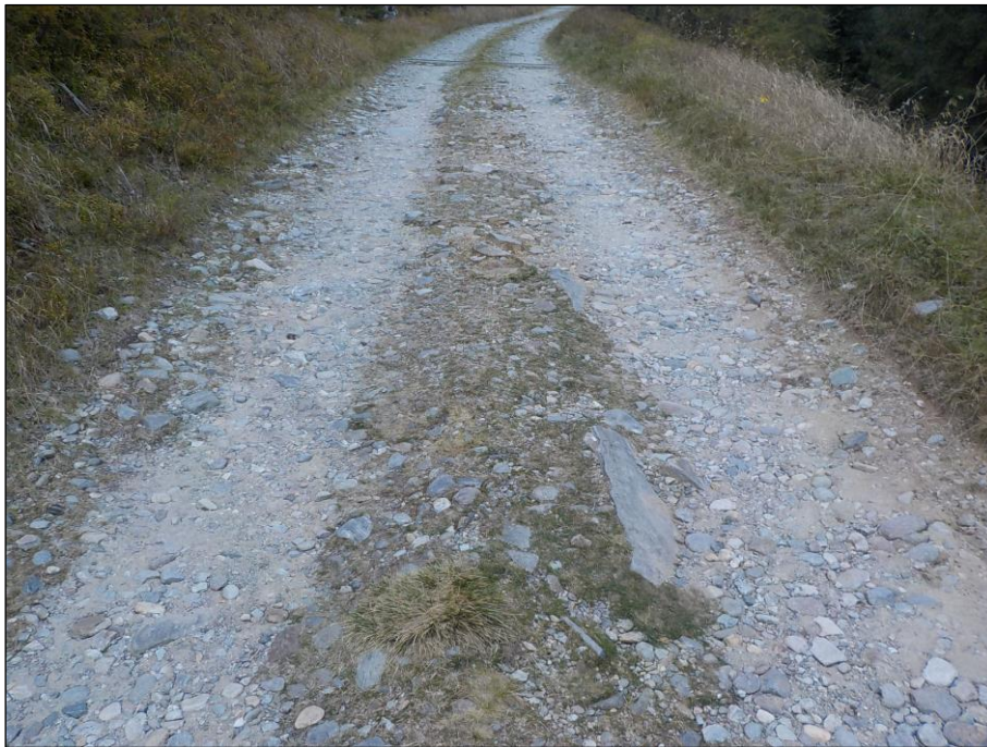
Figura 2: La tratta di strada forestale nella quale verrà posata la condotta per il trasporto d'acqua al nuovo bacino si trova in uno stato precario e verrà pavimentata.
