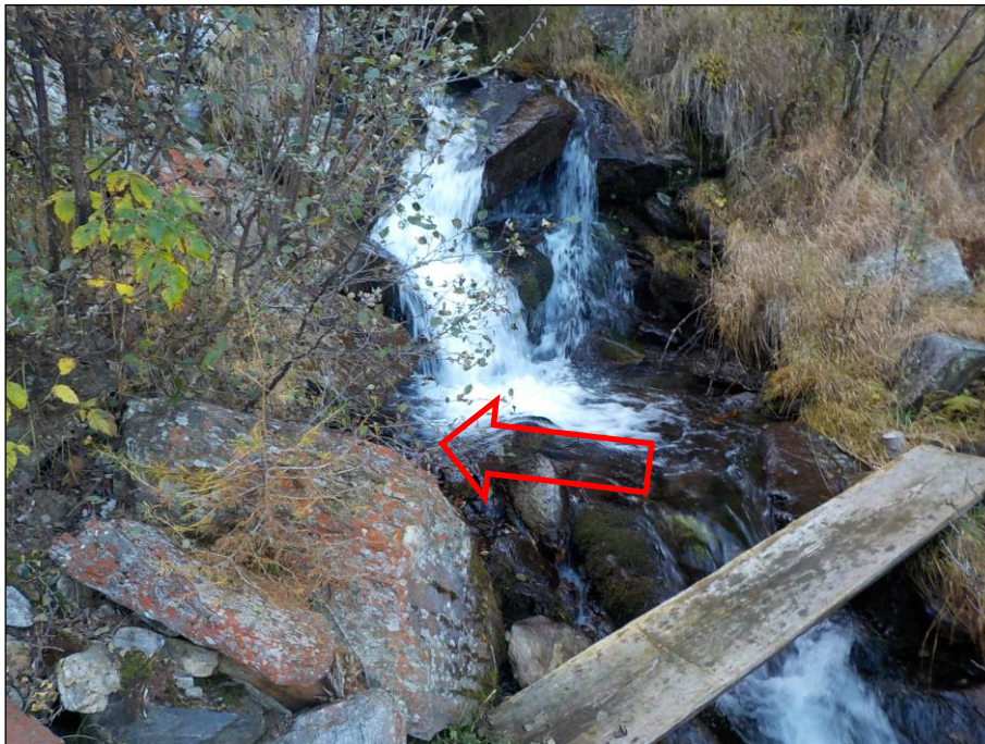
Figura 9: Posa nuova captazione (pozzetto con griglia) ai margini di un pozzo naturale nel Rià dela Pianca.
