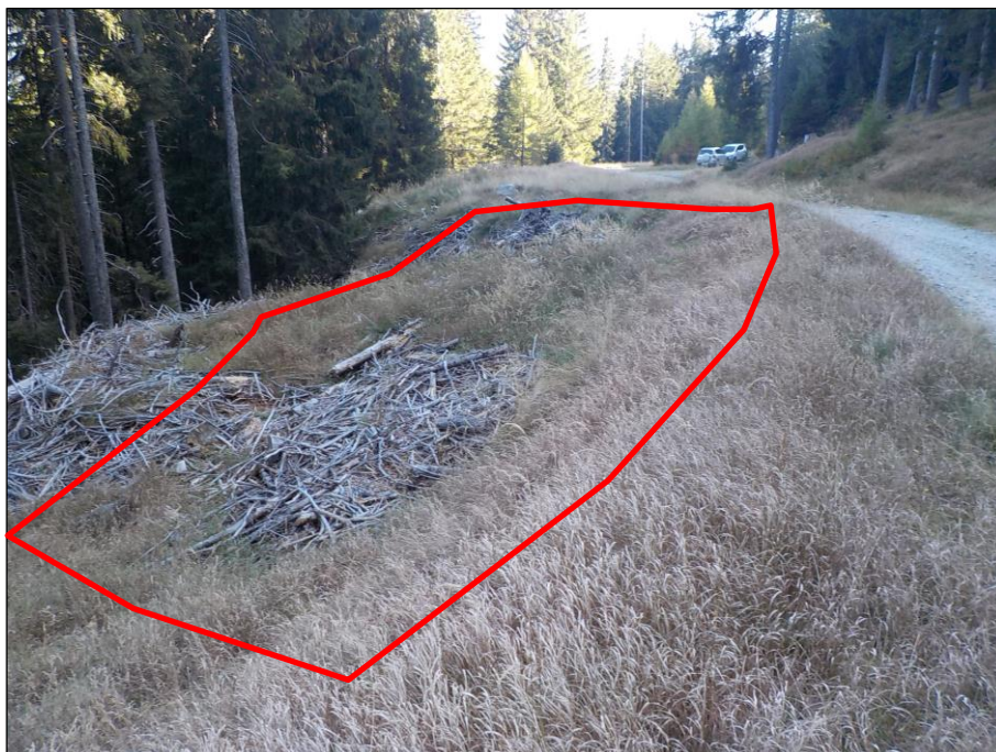
Figura 16: Il materiale in esubero può venir depositato ai margini della strada forestale ingrandendo così il piazzale per il deposito del legname.
