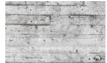
Beton Rohholzschalung
