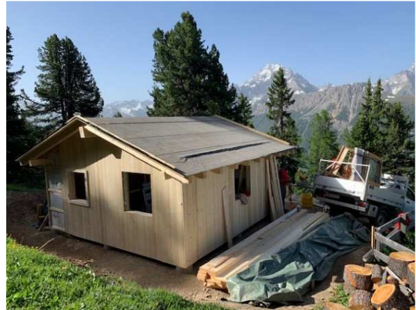
Letzte Bauarbeiten (Fotos: I. Castelberg)
