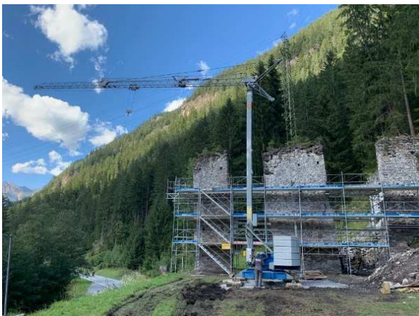
Eingerüstete Mauerpfeiler vor den Bauarbeiten
