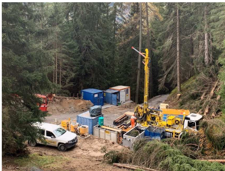
Bohrplatz während den Bohrarbeiten im November 2019 (Foto: C. Guetg)
