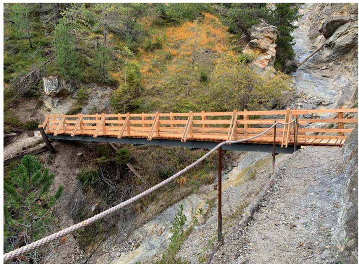
Wanderwegbrücke nach der Räumung der Baustelle (Foto: U. Fliri)
