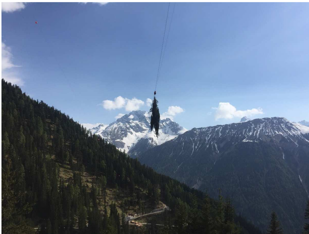
Bringung mit konventioneller Seilkrananlage im God Acla (Foto: C. Guetg)
