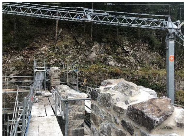
Abschluss der Bauarbeiten bei den Mauerkronen (Fotos: I. Castelberg / T. Wattinger)
