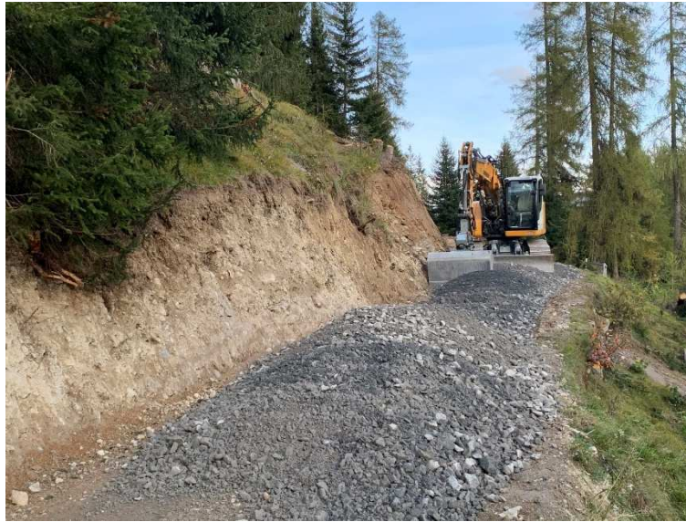
Während dem Koffereinbau im unteren Teil (Foto: C. Guetg)
