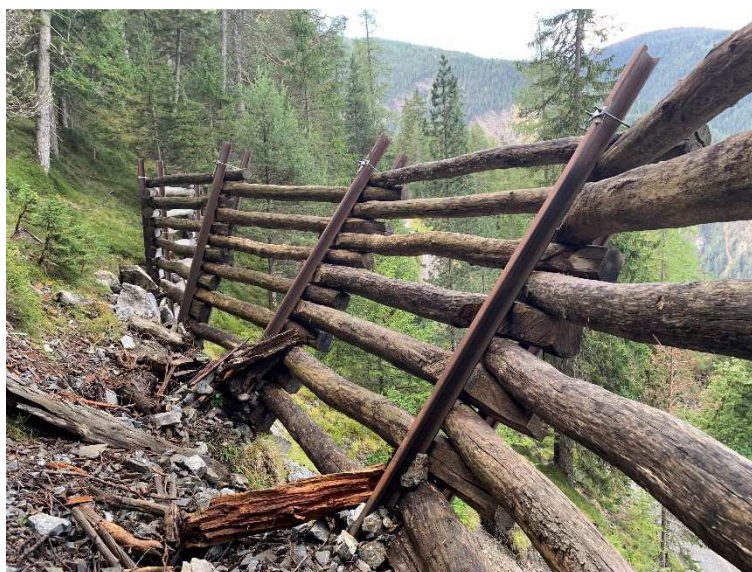
Druckschaden durch Nassschnee (Foto: Urs Fliri)
