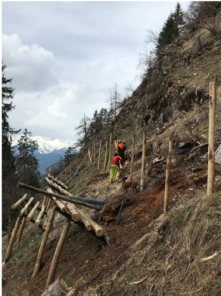
Einzäunung (WSZ 44) der neu erstellten Rempar Grischun (Foto: B. Turner)
