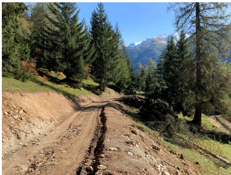
Baupiste bereit für den Koffereinbau (Foto: C. Guetg)
