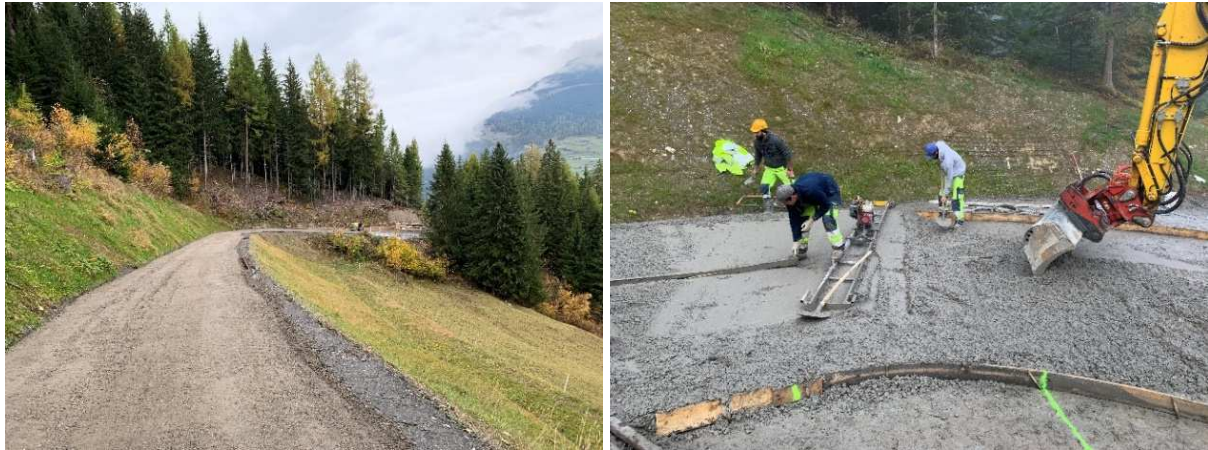
li, fertig eingebaute Planie, re Erstellen einer Betonplatte in der oberen Wendeplatte (Foto: U. Fliri)
