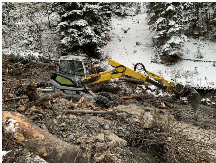
Schreitbagger bei der Räumung des Lawinenholzes, Stulserbach (Foto: U. Fliri)
