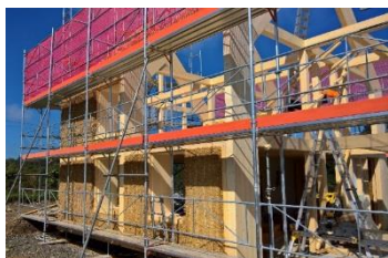
Konstruktion des Strohballenhauses
