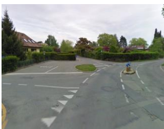
Carrefour des chemins de la Dauphine et de la Foge. Marquage incohérent
