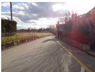
Route de l'Eglise : murs bordant la chaussée avec bande piétonne
