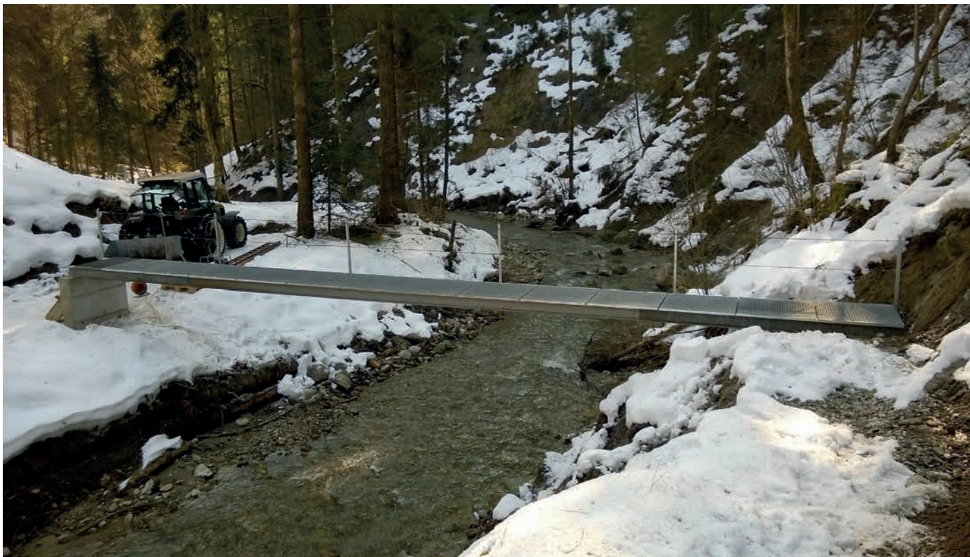
Der neu erstellte Steg (14,5 m) über den Bockengraben.
