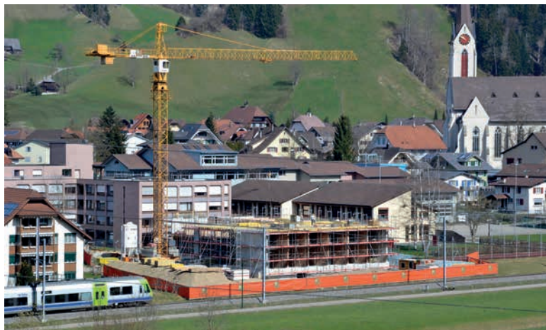
Die Baustelle Altersheim Sunnematte Escholz matt. [Bild gs.]
