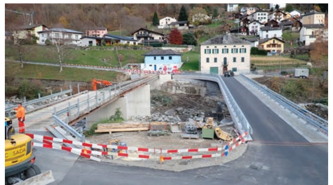
Pont de San Ròch — con demolizione ponte provvisorio
