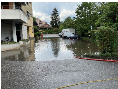
Inondation à l'immeuble communal.
