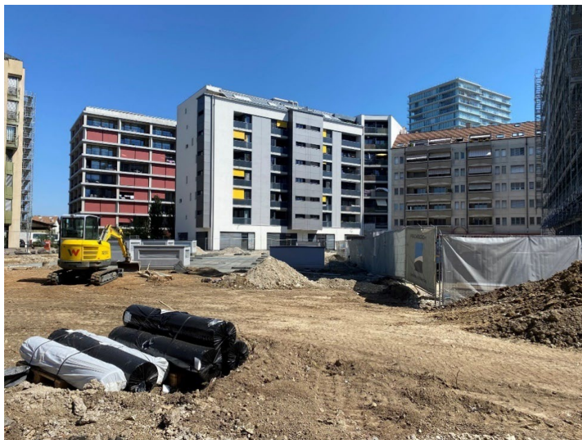
Travaux du parc de la Micheline, août 2022
