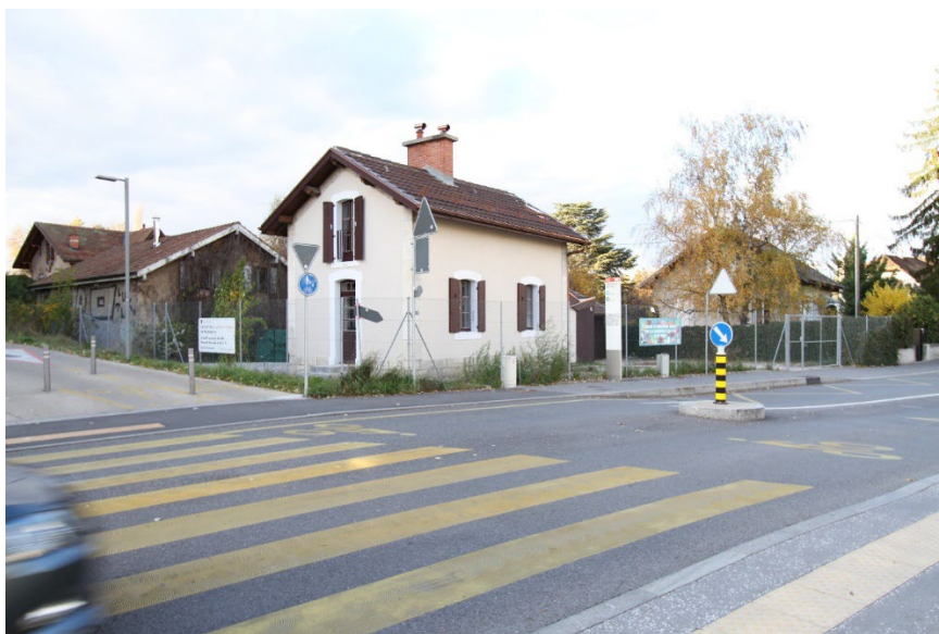
Ancienne maison du garde-barrière
