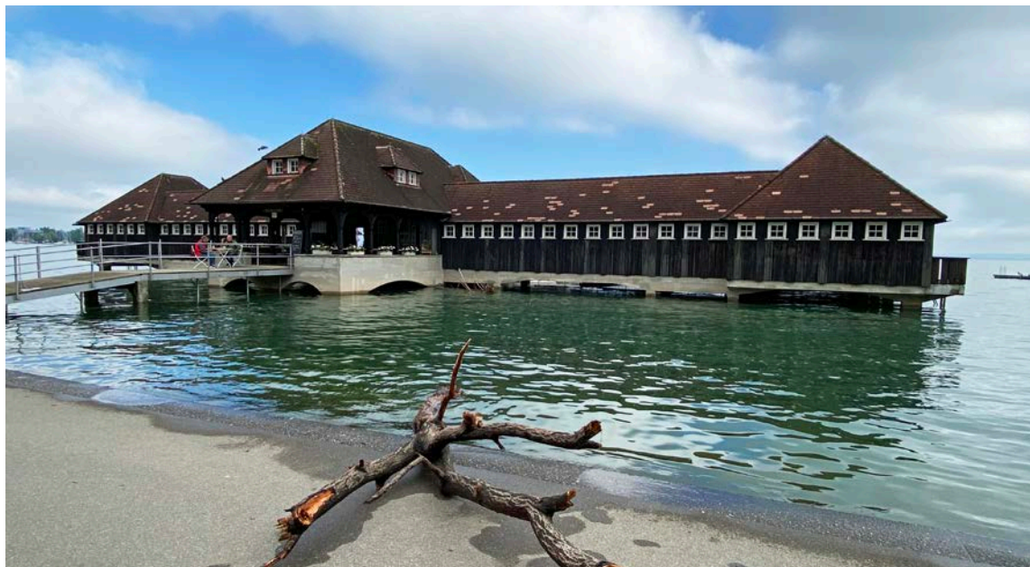
Die Badhütte im Hochwasser vom Juni 2024.
