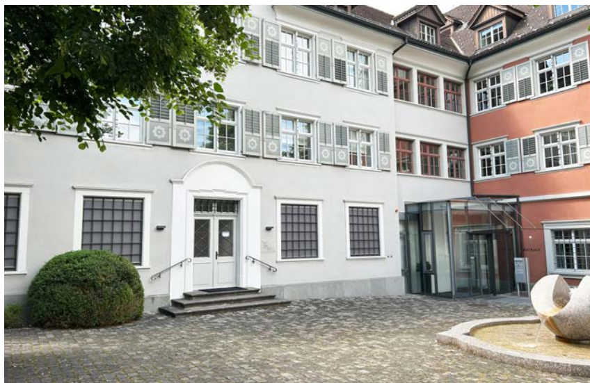
Die Büros des regionalen Zivilstandsamts verfügen neu über einen separaten Zugang gleich neben dem Haupteingang des Rathauses.
