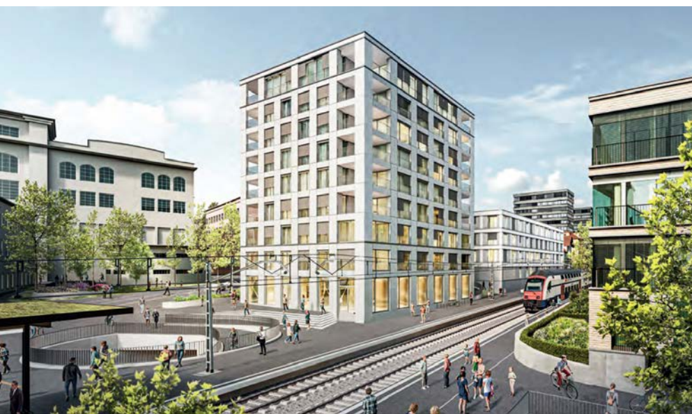
Das Bauvorhaben Stadtbahnhof Süd grenzt direkt ans Plangebiet Feldmühle.
