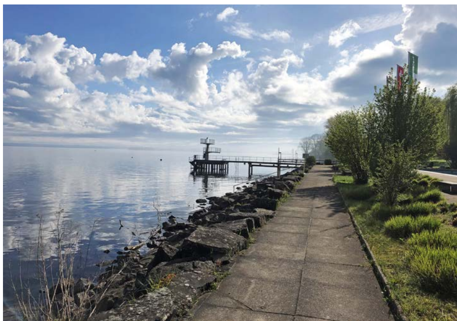
Die harte Verbauung des Seeufers soll im Bereich des Strandbades verschwinden.
