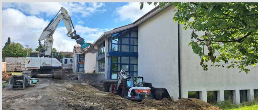
Baggerarbeiten beim unteren Eingang.
