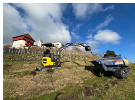
Mit einem Bagger werden die alten Reben im unteren Teil des Rebbergs entfernt.
