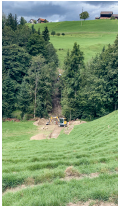
■ Zwischen Schwarzholz und Freudwil wurde eine neue Pumpleitung verlegt.
