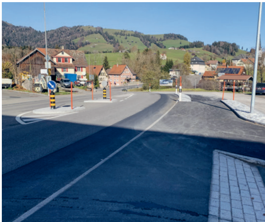
■ Die Wattwilerstrasse kann dank der Mittelinsel sicherer überquert werden.
