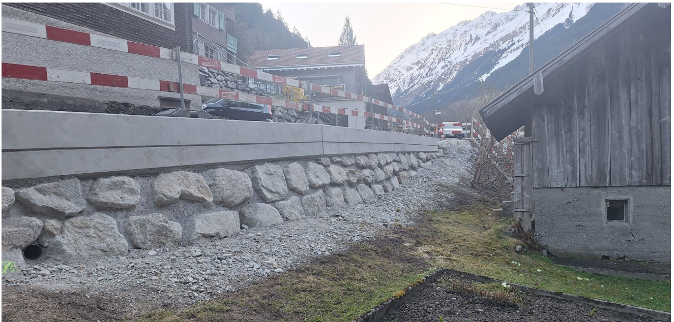
Foto: Sanierte Stützmauer im Bereich Chohlplatz, Bristen
