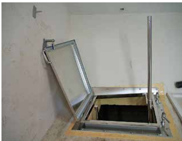
Einstiegsdeckel mit Leiter zur Wasserkammer
