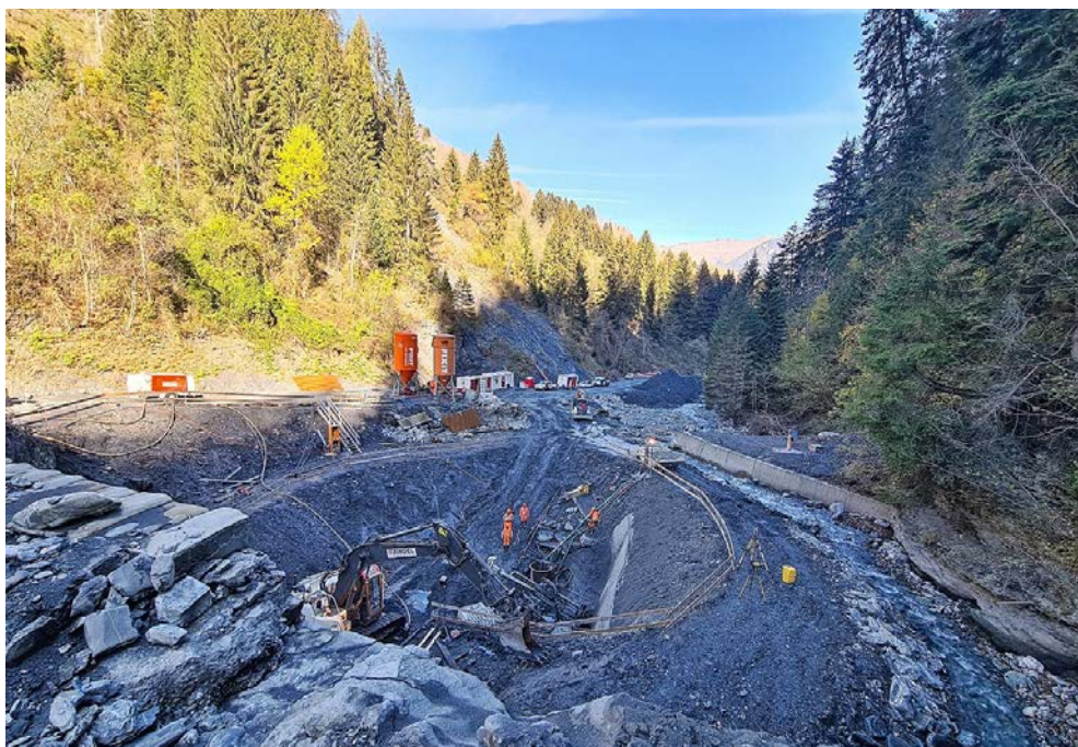
Das grosse Sorgenkind der Nollaverbauungen: Sperre 8 war 2020 stark beschädigt worden. Vergangenen Herbst begannen die Bauarbeiten, sie dauern bis Ende 2023 an.
