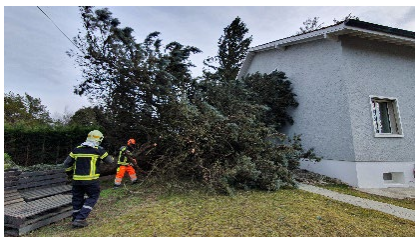
Arbre tombé sur une maison lors des intempéries du 26 février.
