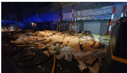
Incendie au pied de l'un des immeubles du parc Dinu Lipatti le 26 mai aux environs de minuit.
