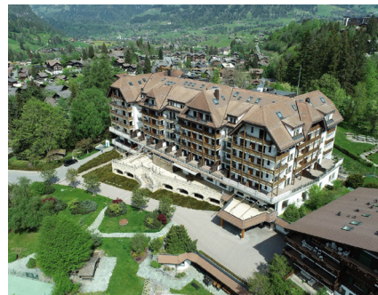
Abb. 5 Sicht auf das Planungsareal mit dem Hotelgebäude in Richtung Norden (Quelle: Jaggi Swiss)
