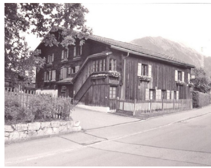
Abb. 20 geschütztes Gebäude an der Wispielenstrasse 37 (Quelle: Objektblatt Bauinventar)
