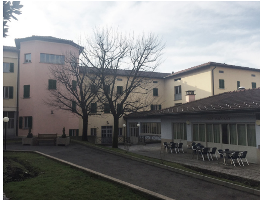
corte interna ( vista sud-est)
