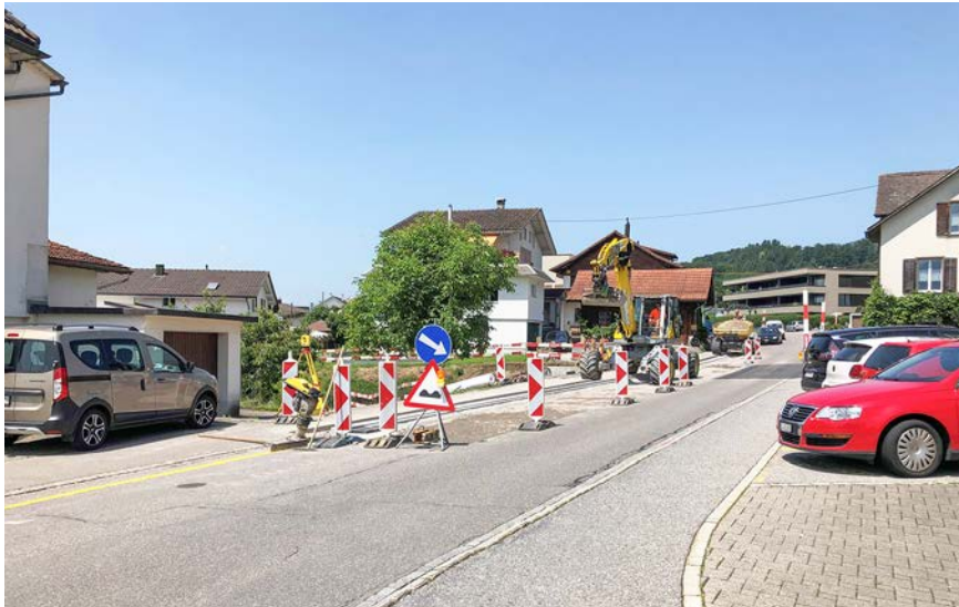
■ Die Sanierungsarbeiten bei der Ernetschwilerstrasse haben begonnen.
