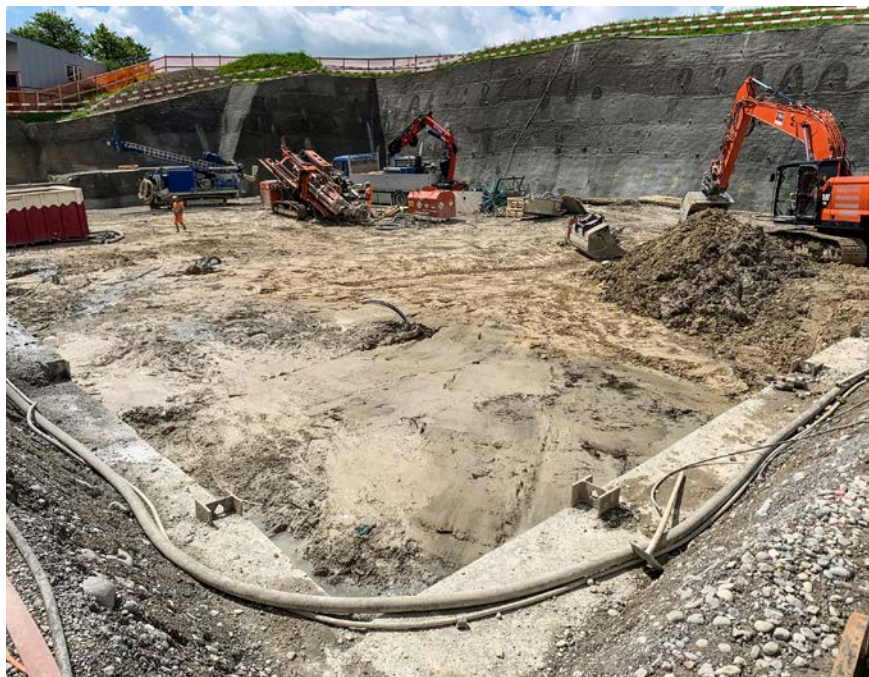
■ Die Aushubarbeiten schreiten voran.
