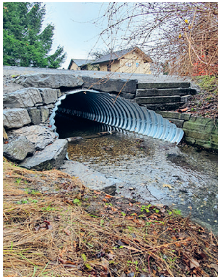
Blick nach Süden auf den neuen Durchlass.
