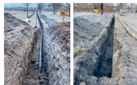
Bereich Wiese Freibad, Bau Frischwasserzuleitung.
