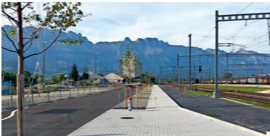
Blick nach Norden auf die neue Güterstrasse.
