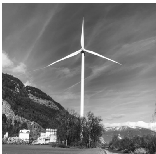
Windenergieanlage in Haldenstein (GR)
