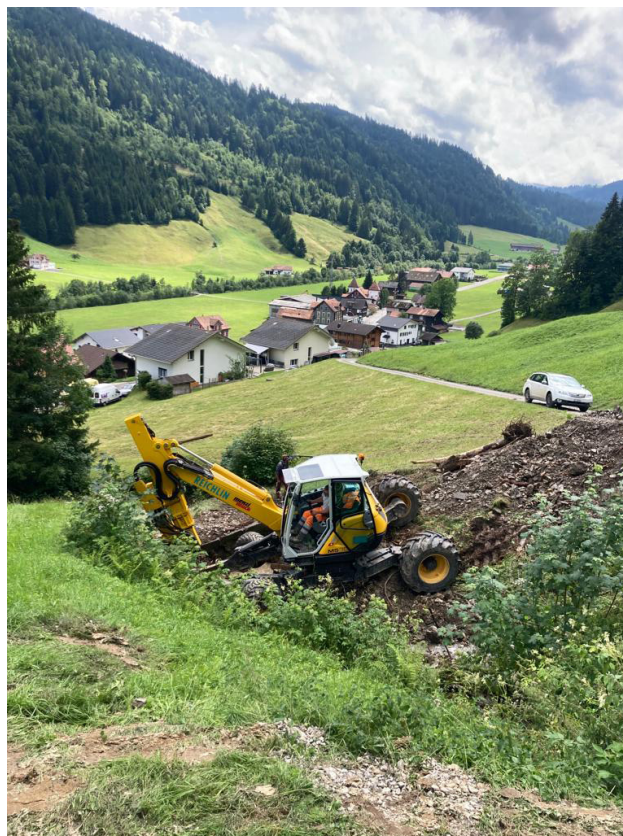
Aufräumarbeiten am Geissbergbach nach Unwetter 2021
