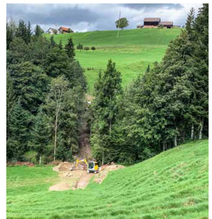
■ Die neue Hydrantenleitung durchquert den Eichermülibach im Schwarzhölz in Ernetschwil.
