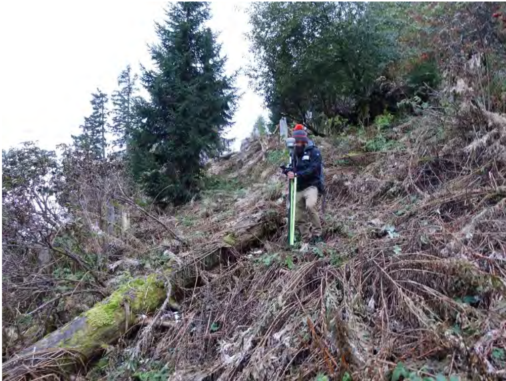
Abbildung 8g. Waldzustand im Bereich einer Windwurffläche (Sturm Lothar, Dezember 1999). Hier wird für die Gondelbahn eine Schneise geschlagen und eine Stütze aufgestellt werden.
