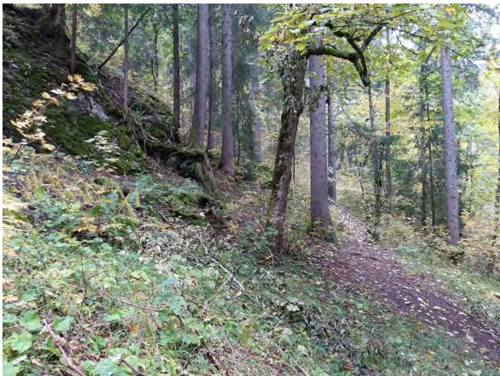
Abbildung 8c: Das Gondelbahntrasse wird hier von rechts unten nach links oben verlaufen. Im Fichten-Tannenwald wird eine Schneise geschlagen und eine Stütze aufgestellt
