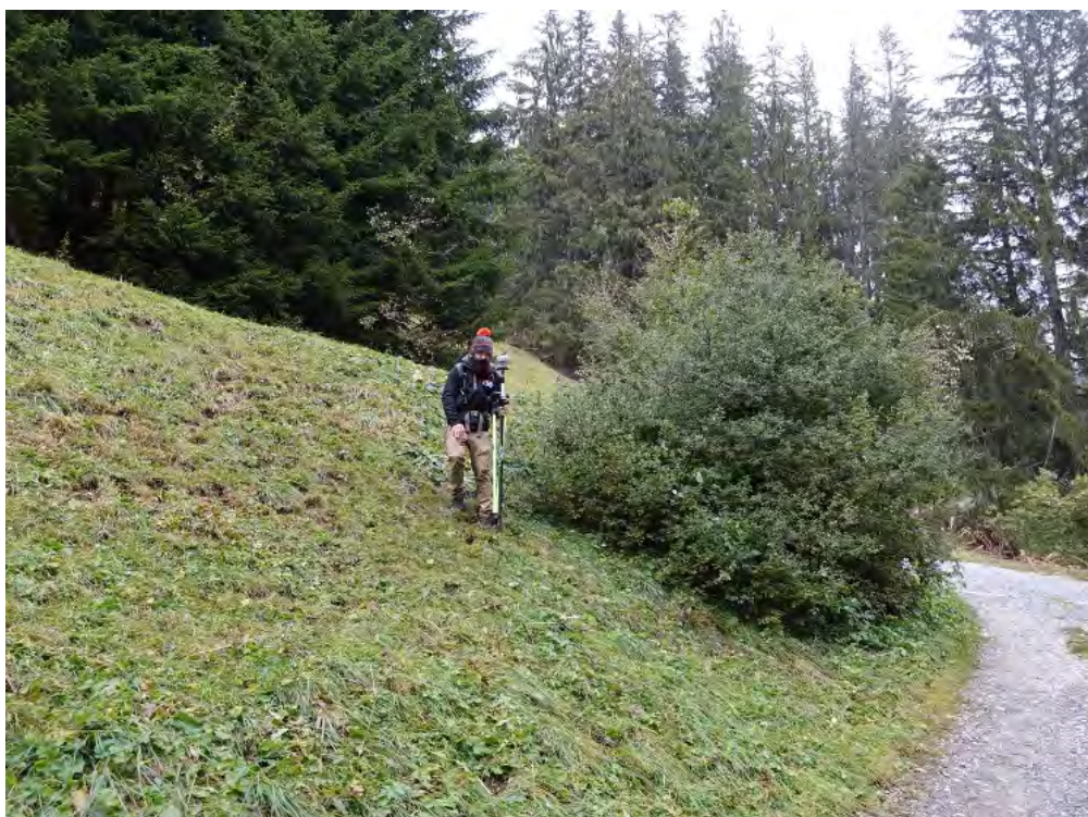
Abbildung 8f. Hier wird eine Stütze in der Nähe der Alperschliessungsstrasse errichtet werden. Die Bauerbieten können von der Strasse aus ausgeführt werden (keine Baupiste erforderlich).
