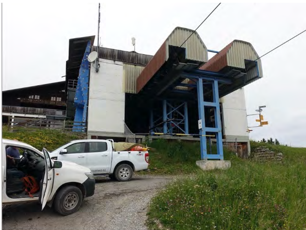
Abbildung 6c: Die Bergstation der alten Gondelbahn wird abgebrochen und an der gleichen Stelle durch eine neue Station ersetzt.
