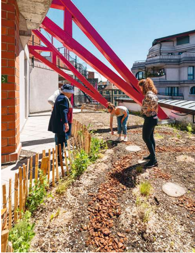
Les toitures-terrasses des Schtroumpfs arborent de nouveaux îlots de fraîcheur.
