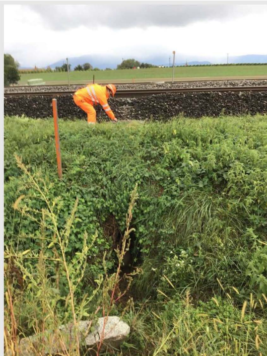
V1 – km 21.954 – Vue aqueduc existant
