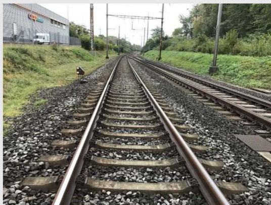
V1 – km 21.300 vue côté Lausanne
