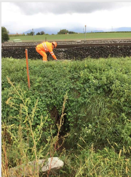
V1 – km 21.954 – Vue aqueduc existant
