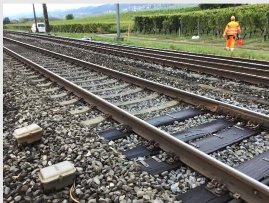
V315 – km 22.409 début de réfection côté Lausanne
