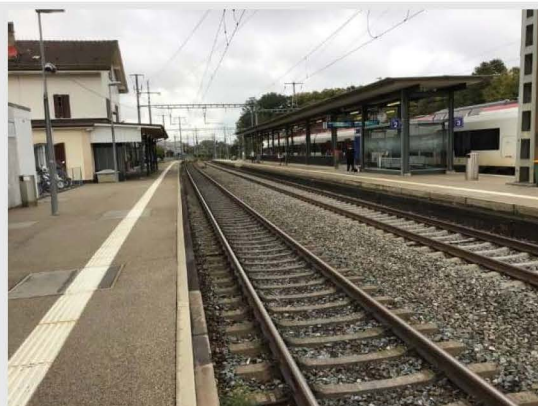
V1 – km 21.600 vue côté Lausanne
