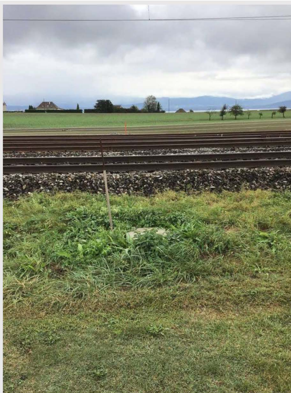
V1 – km 22.245 – Vue aqueduc existant
