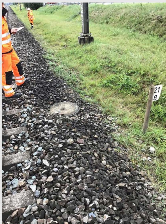
V1 – km 21.800 – chambre du drainage existant dans le gabarit
