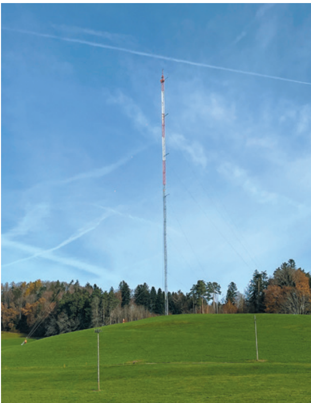
Der im Gebiet Sackgrütli errichtete Windmessmast
