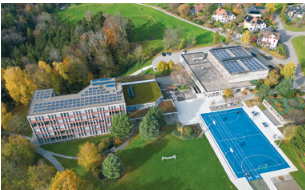
Die PV-Anlagen auf dem Oberstufenschulhaus und der Turnhalle Lerchenfeld
