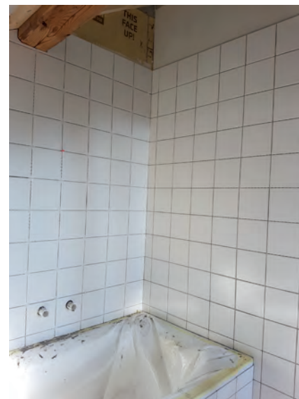
pose du carrelage au mur
