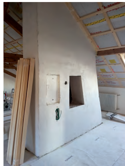
lissage de la cheminée par le plâtrier-peintre
