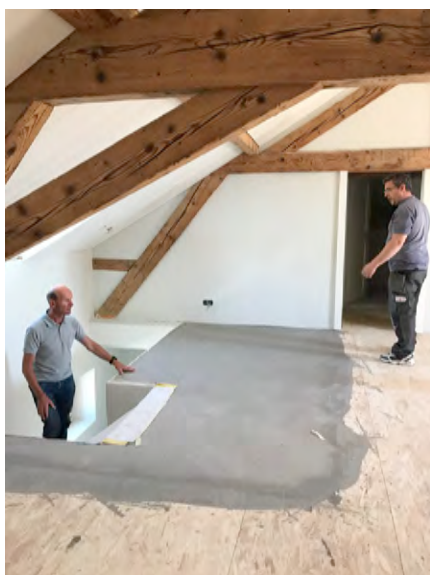
préparation des sols pour la pose du parquet
