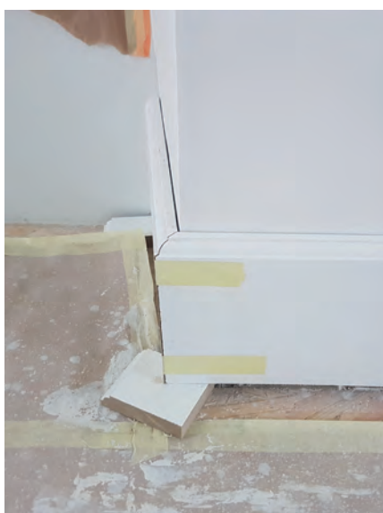
pose des plinthes par le menuisier et peint par Rochat
