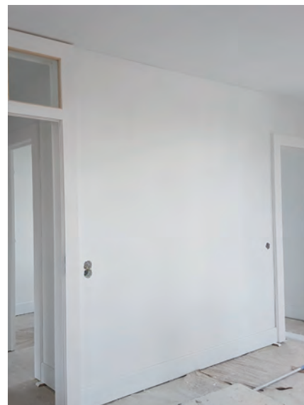
pose du variovlies pour la couche finale de peinture
