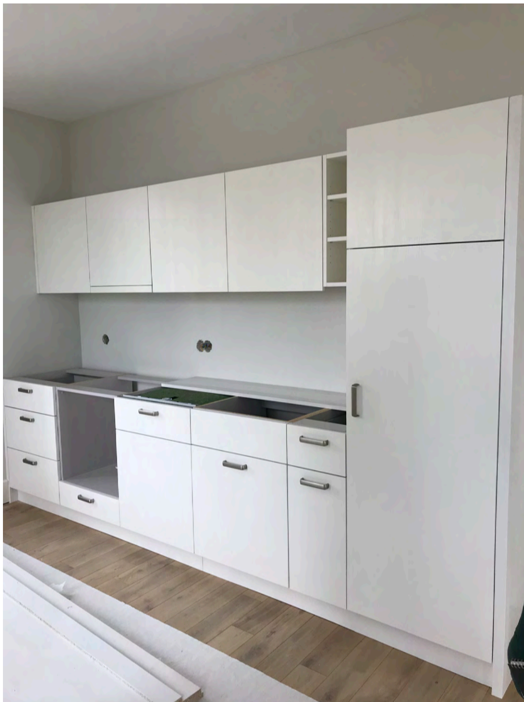
pose des cuisines dans les appartements par le menuisier Dürig
