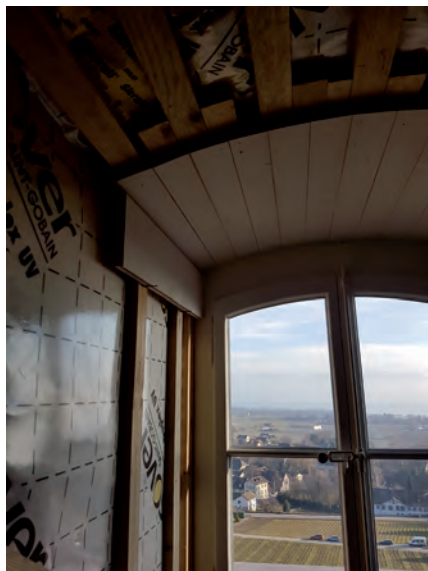
échantillon des lames bois dans les lucarnes
