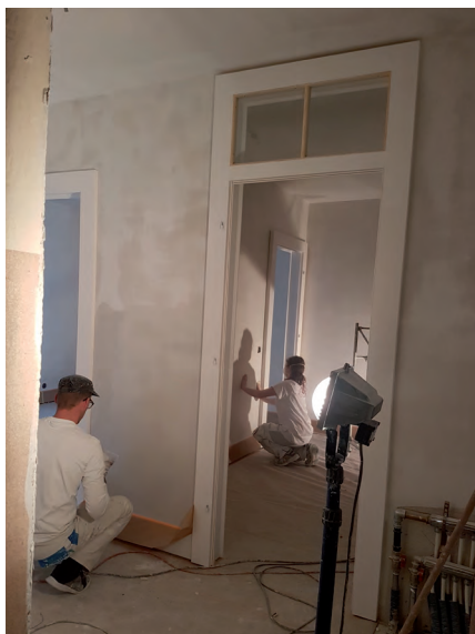
fin du lissage des cloisons
