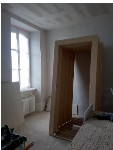
livraison sur le chantier des cades de portes de communication
