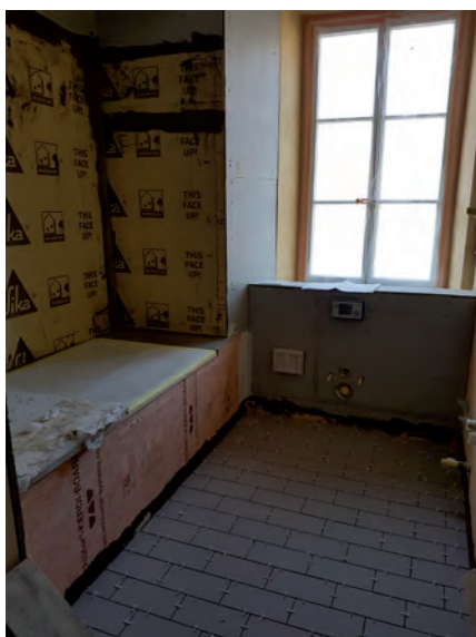
pose du carrelage au sol par l'entreprise Stoppa
