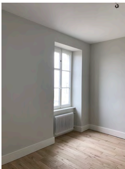
peinture des appartements terminée pose du parquet en cours
