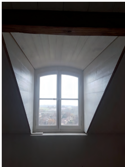
pose terminée des lambris bois dans les lucarnes
