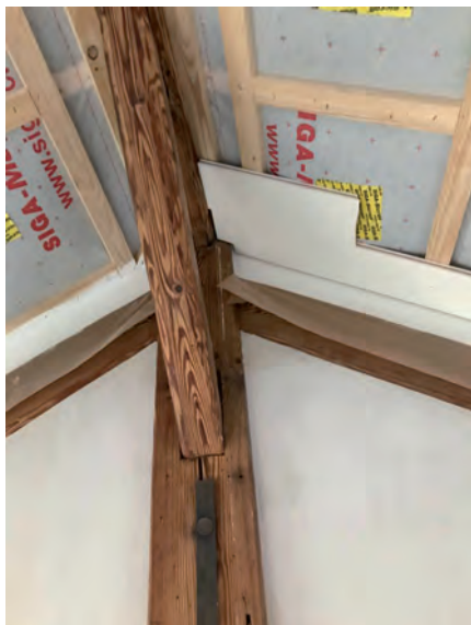
échantillon des lames bois, lambris des combles
