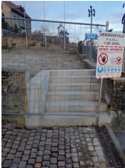
escalier église - jardin coulé par l'entreprise Debonneville fin 2019
