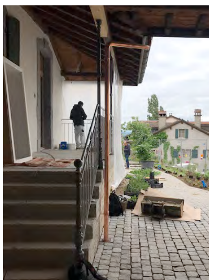
pose du nouveau garde-corps perron entre piliers existants.
