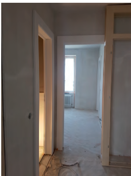
pose des cades de portes
