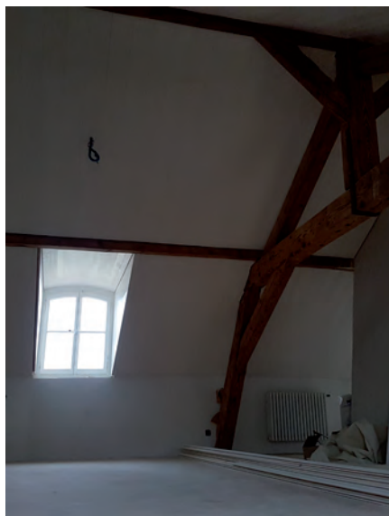
pose des lambris bois dans les comble par le charpentier
