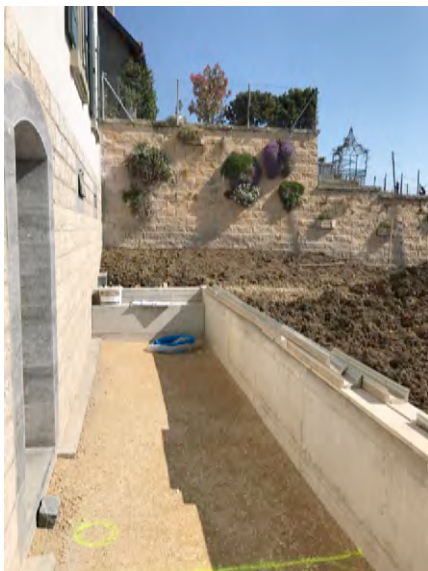
terrassement, mise à niveau
