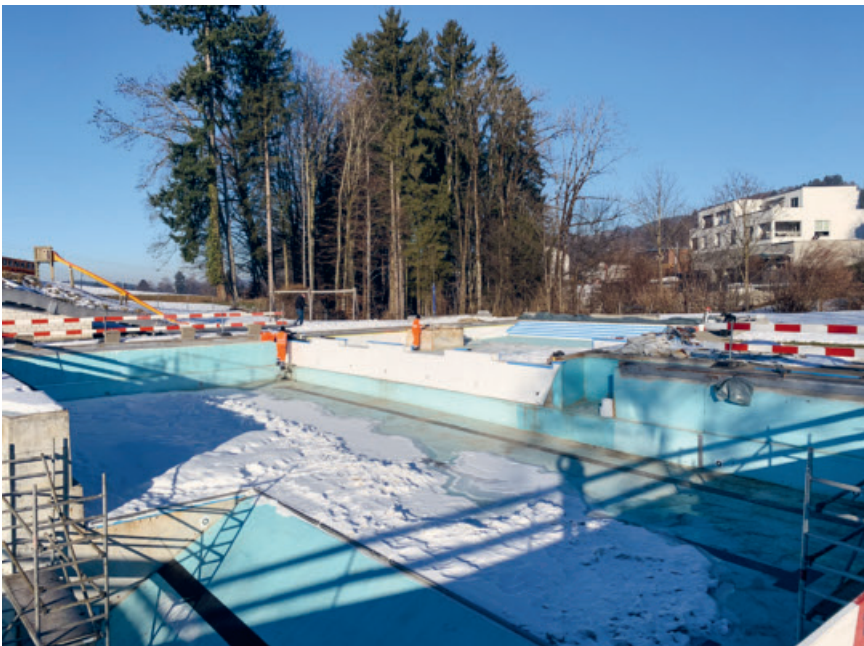
■ Das Schwimmbecken der Badi Gommiswald wird neu ausgekleidet.
