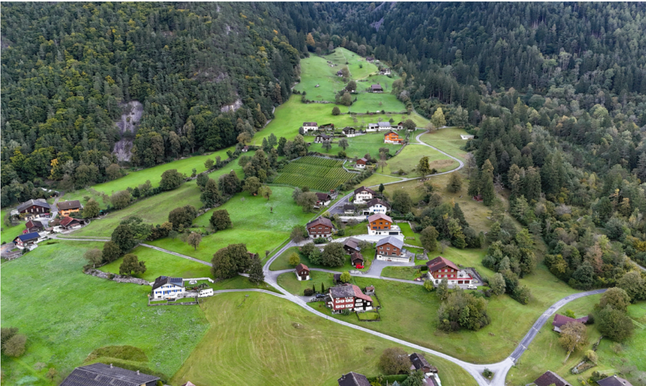
Bild: Luftaufnahme der oberen Buchholzstrasse, die ab 22. Juni 2026 saniert wird.
