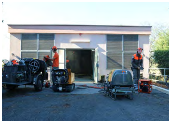
Travaux sur le nouveau site de Prangins
