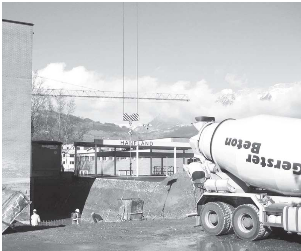
Ende Februar 2014: Die Bodenplatte zum Erweiterungsbau wird betoniert.
