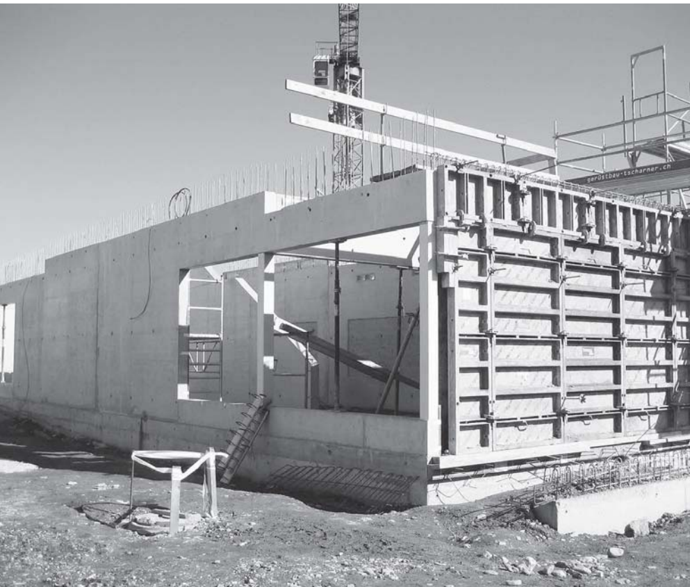
Anfang März 2014: Der künftige Eingang zur neuen Tagesstätte steht im Rohbau. Die in Sichtbeton gehaltenen Wände des Kindergarten- und Tagesstätten-Neubaus erfordern etwas mehr Arbeits- und Zeitaufwand.
