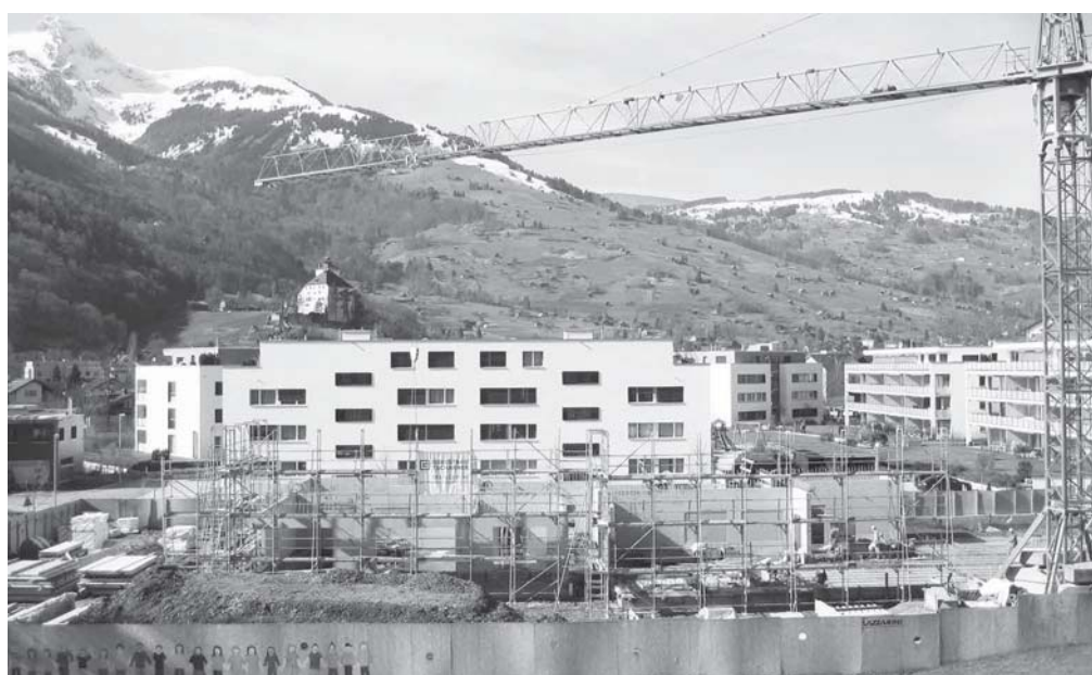
Anfang März 2014: Etwa die Hälfte der Wände des Untergeschosses (Kindergartenbau) sind hochgezogen.
