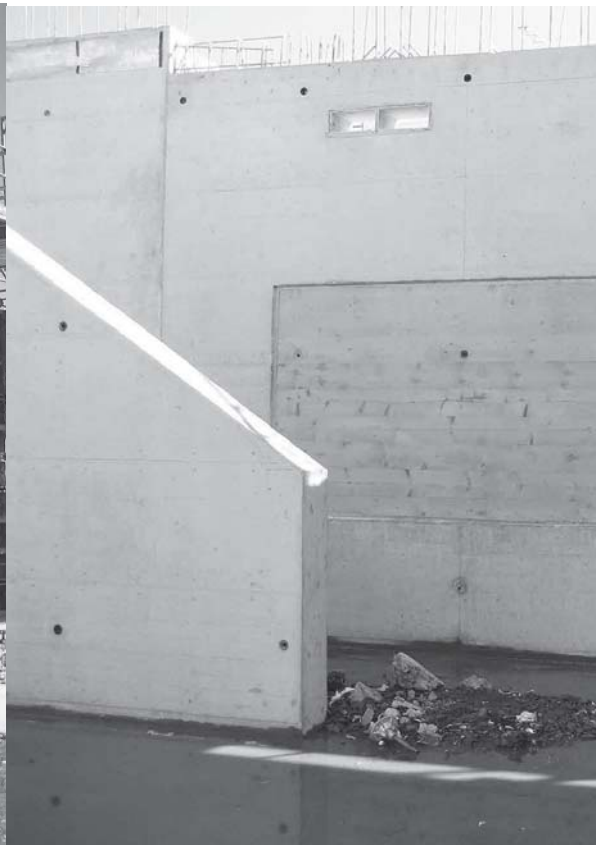
Anfang März 2014: Der künftige Eingang zur neuen Tagesstätte steht im Rohbau. Die in Sichtbeton gehaltenen Wände des Kindergarten- und Tagesstätten-Neubaus erfordern etwas mehr Arbeits- und Zeitaufwand.
