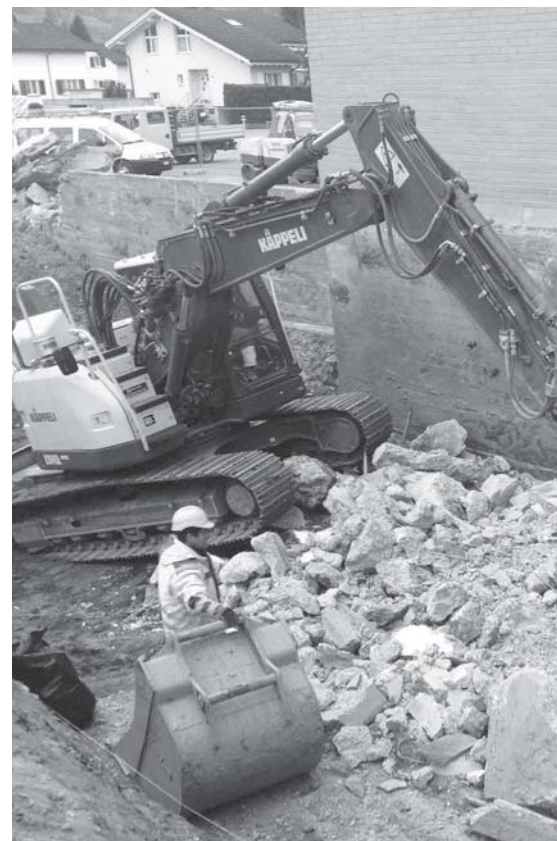
Mitte Februar 2014: Der Abbruch
