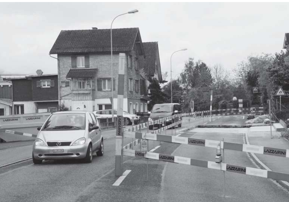
Vorübergehende Behinderungen: Die Bauarbeiten bei der Tobelbachbrücke an der Kantonsstrasse haben begonnen.
