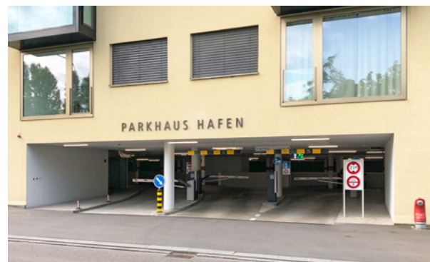
Das Parkhaus Hafen verfügt neu über zwei öffentliche Ladestationen für E-Autos.
