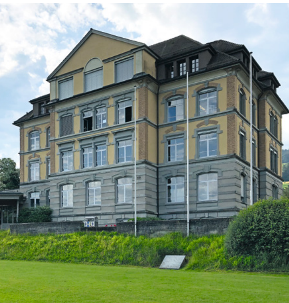
13 Erdsonden liefern aus 295 m Tiefe Wärme für die Schulanlage Kreuzacker.
