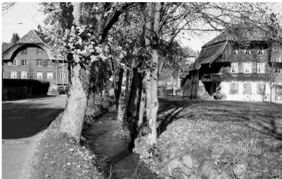
Abbildung 24 Links: Bernstrasse mit nicht mehr vorhandener Doppelbaumreihe und früherem Bachverlauf (Gewerbekanal), Rechts: Parzelle «Walki» mit Bestandsbau (Fotoaufnahme ISOS)
