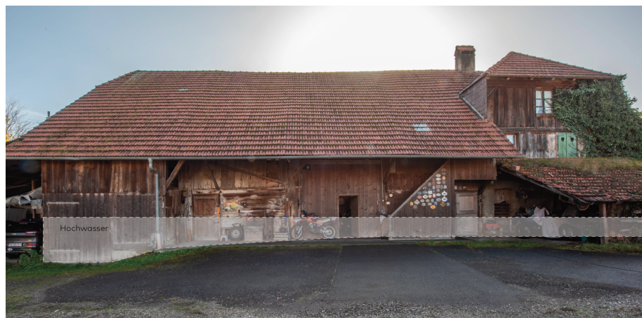
Abbildung 3: Bestandsbau mit visualisierter Hochwasserschutzkote
