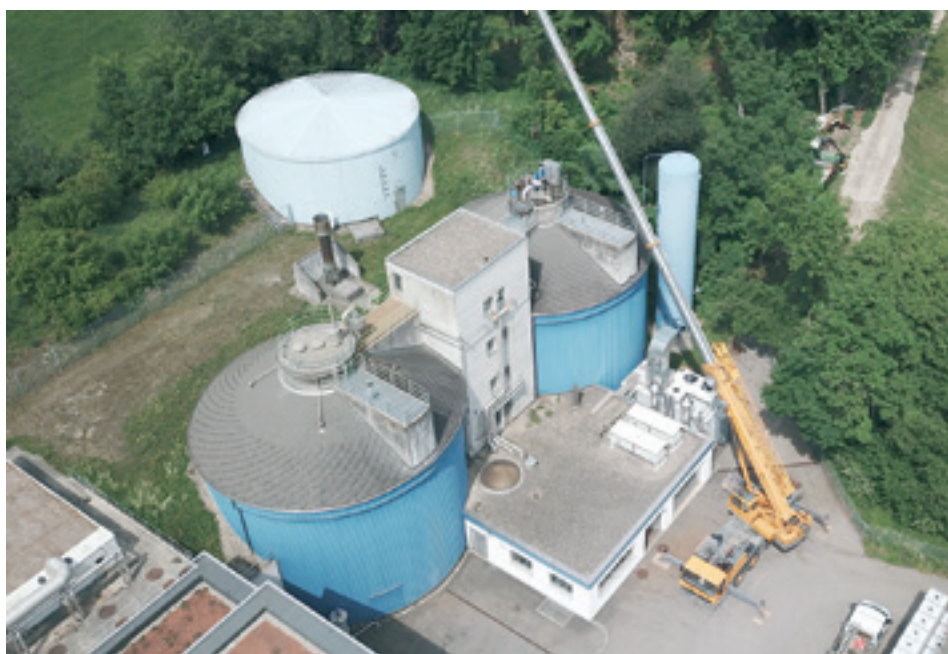
Vorfaulraum und Stapelraum der ARA Bazenheid
