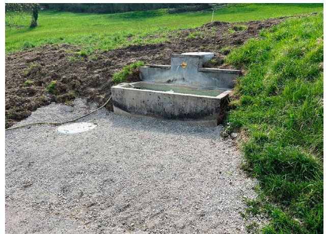
Brunnen Hueb: Wasser fliesst wieder
