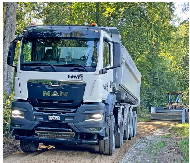
Einbau neue Verschleisschicht
