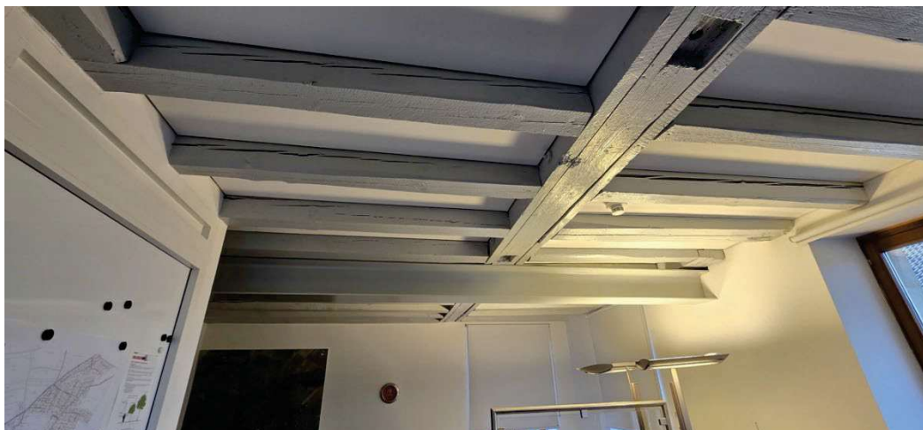
Plafond bureau premier étage
