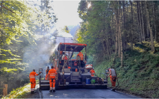
Belagseinbau Triebbernstrasse, Weissbad
