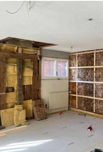
Entfernen der alten Isolation
