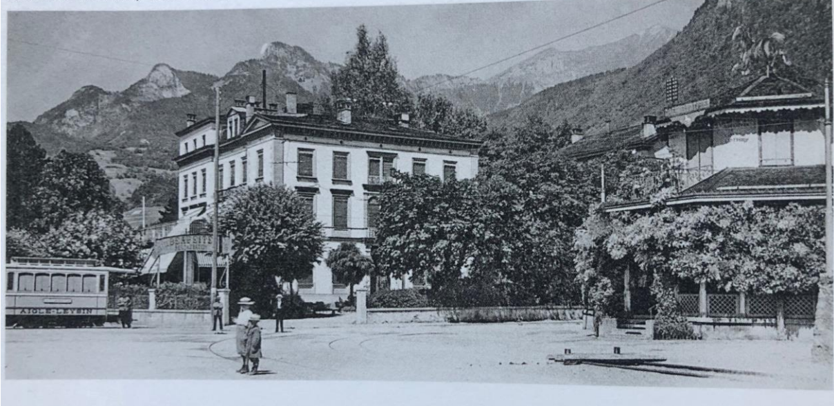
Site et le Pavillon, vers 1902.
