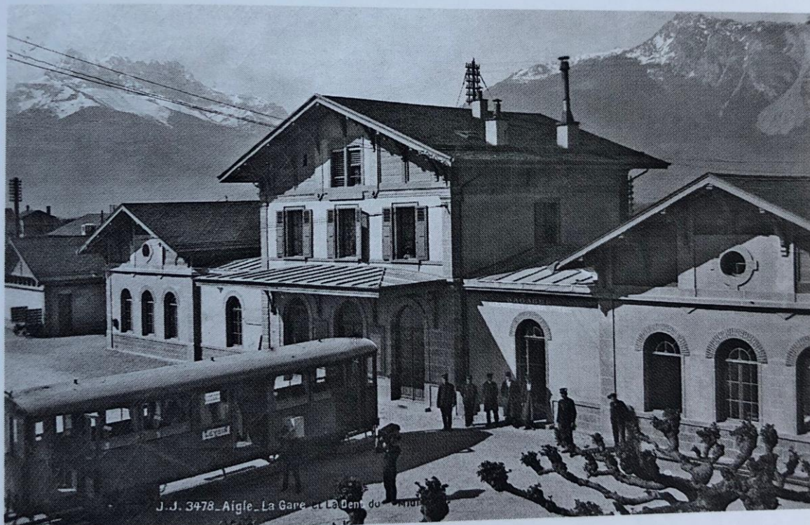
Fig. 7.53 - La gare d'Aigle après son agrandissement de 1909 avec une voiture de l'Aigle-Leysin vers 1910, vues de l'hôtel Beau Site.
