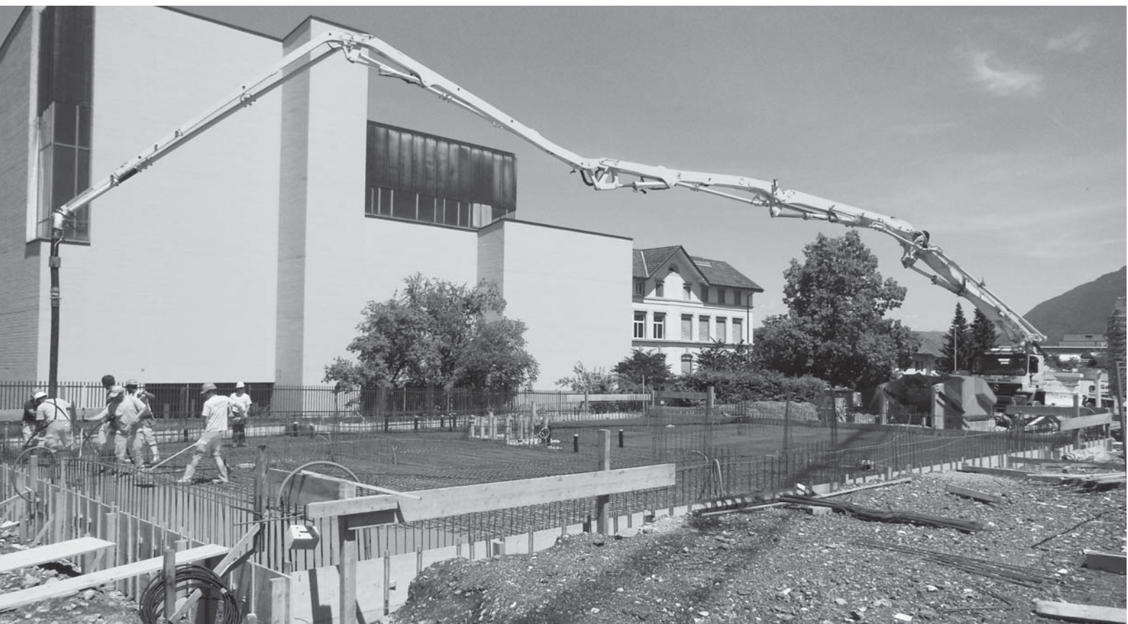
Baustelle Grof: Im Juni 2014 konnte mit der Erstellung des Betonfundaments begonnen werden.
