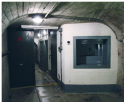
Beengend, kalt und wenig einladend – das Innenleben der Anlage.
