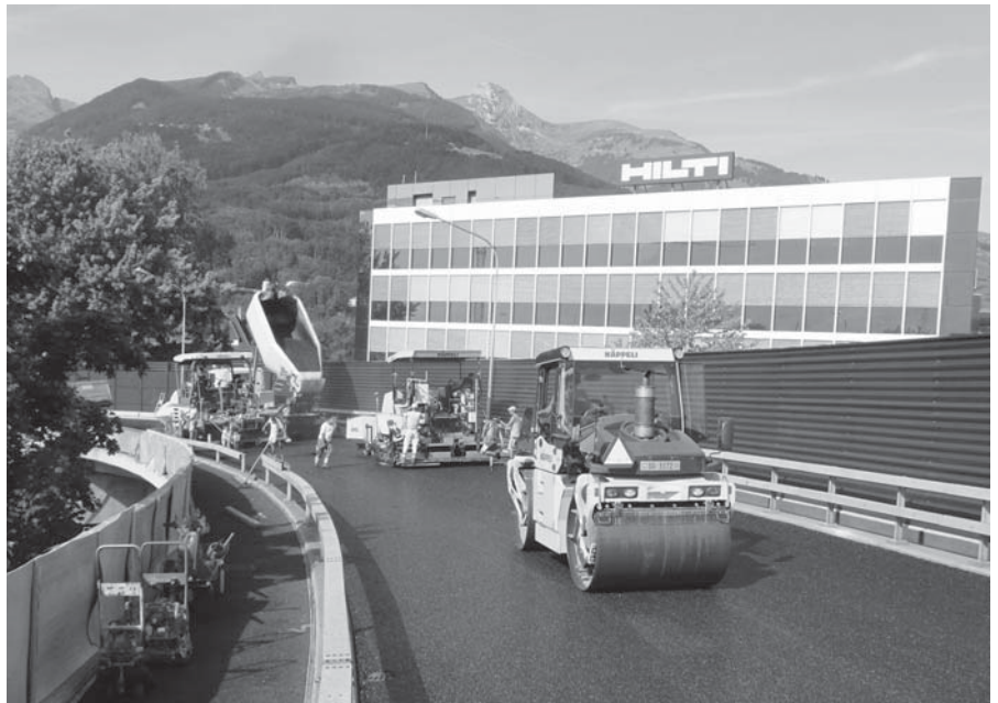
Einbau der neuen Fahrbahn
