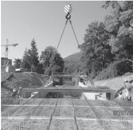
Einbringen der neuen Elemente
