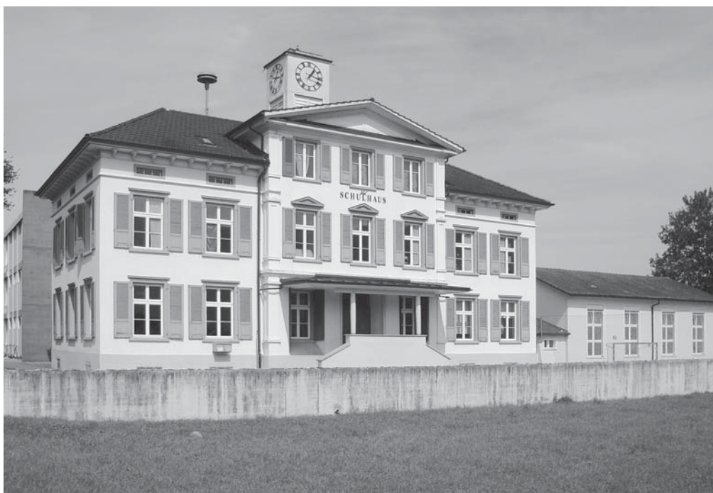
Das historische Schulhaus von 1883 ist in die Gesamtanlage integriert
