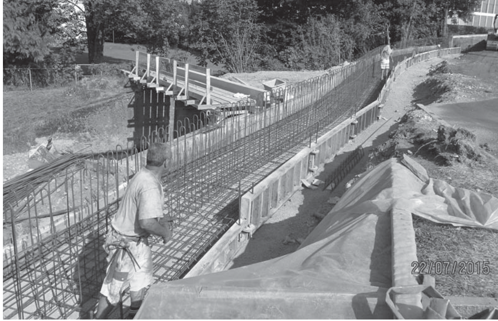
Einbau der neuen Fundamente und Aufschüttung der neuen Fahrbahn
