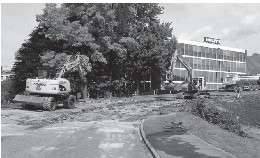
Beginn der Bauarbeiten: Die Fahrbahn und die Lärmschutzwand werden zurückgebaut.
